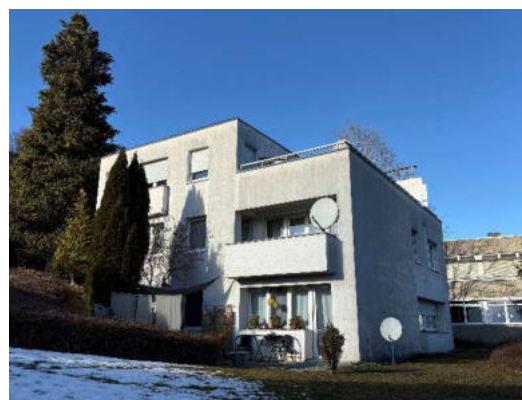
Johannes-Raster-Straße vor der Sanierung
