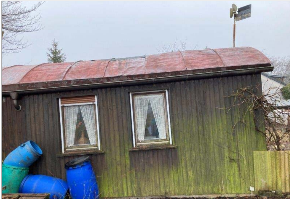
Abb. 7: Bauwagen aus Holz im Bereich des ehemaligen Gartengrundstücks (Flst. Nr. 1853) (Foto: HPC AG, 07.03.2024)
