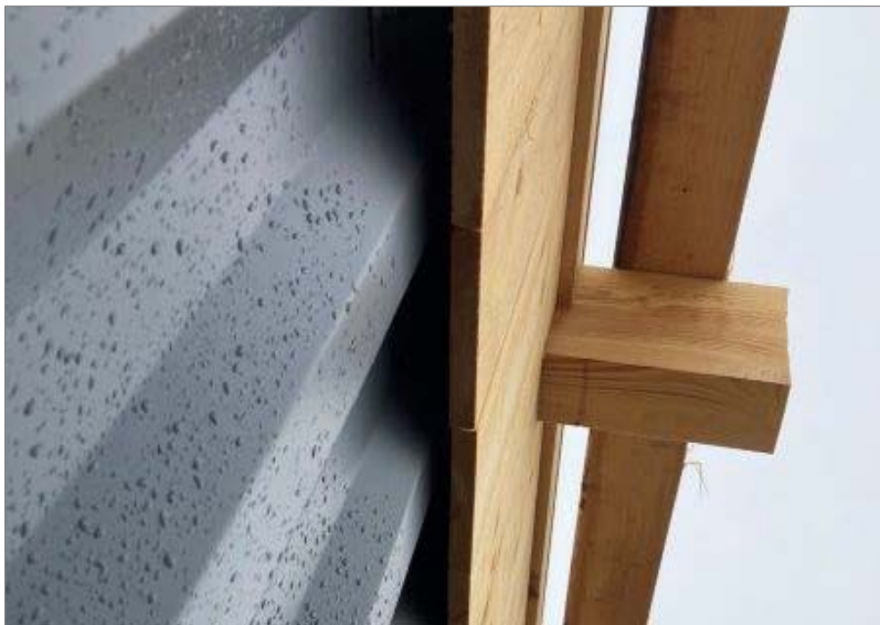
Abb. 12: Mit Holz verkleideter Baucontainer (Flst. Nr. 1910) (Foto: HPC AG, 07.03.2024)
